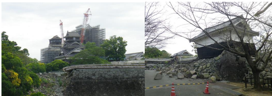
事前に、復旧工事中の熊本城にも立ち寄りしました
